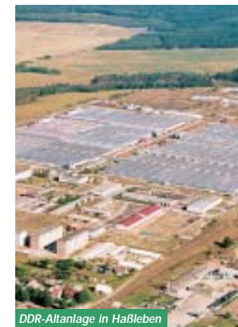
DDR-Altanlage in Haßleben
